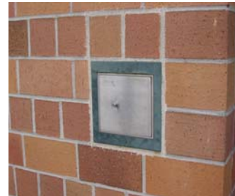
Bild: Feuerwehr-Schlüsseldepot
